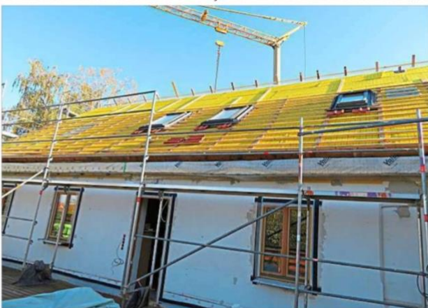
In Niedertaufkirchen sind die Arbeiten voll in Gange. Das Dach des „ConnectionHouse“ wird energetisch saniert und erhält Solarmodule. – Fotos: Jaensch
