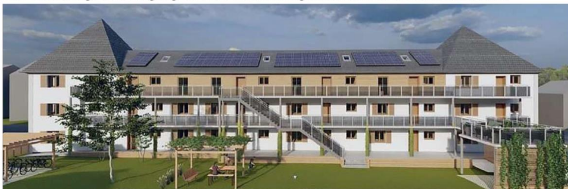
So soll das Genossenschaftshaus auf der Ostseite künftig aussehen: Der Mitteltrakt soll aufgestockt werden, auf dem in Folge des Ausbaus flacheren Dach eine PV-Anlage installiert werden. Die Wohnungen in den Obergeschossen sollen durch einen Laubengang erschlossen werden. – Visualisierung: Bubl
